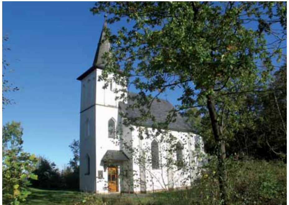
Bergmerkapelle – Baubeginn am 8. Juni 1904
