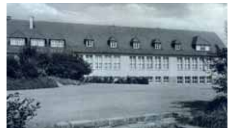
Das jetzige Schulgebäude wurde am 28. Februar 1952 eingeweiht und ist durch Um- und Anbaumaßnahmen 1970 den Erfordernissen der damaligen Zeit angepaßt. Der Pausenplatz wurde auf die Nordseite des Gebäudes verlegt.
