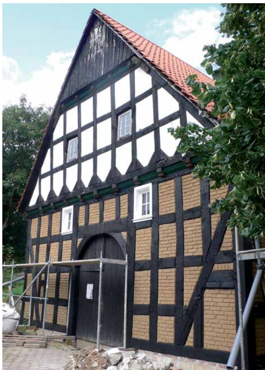
Jede Menge Arbeit steckt in der Rekonstruktion des Hauses
