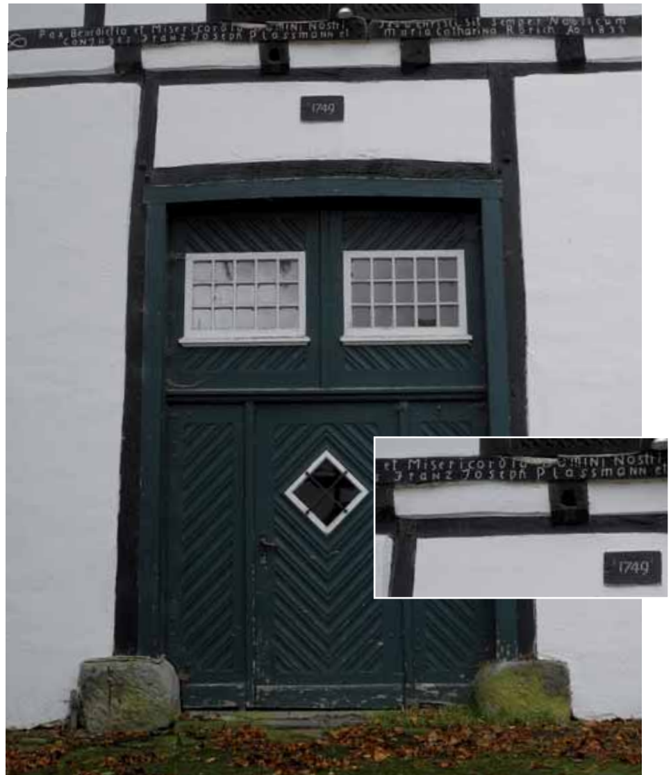
Deelentor des Hofes zum Broich – Mathias Zumbroich ließ 1749 den Hof in Fachwerkbauweise neu errichten.
