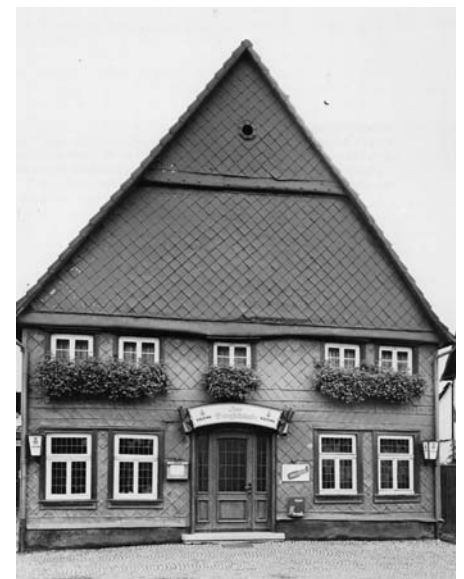
Bild 5: Giebelverkleidung Burgschänke, Hachen mit Formblechen, (Baujahr 2. Hälfte 18. Jahrhundert, Foto Friedhelm Ackermann, 1985)
