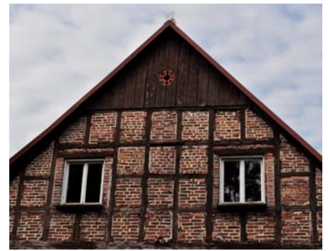
Bild 8: Sundern-Amecke, Illingheimer Straße 21, (Baujahr 1876)
