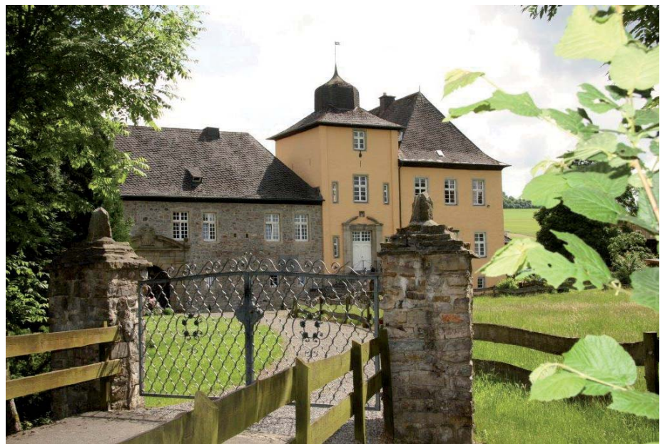
Das Haus Amecke nach umfangreichen Renovierungsarbeiten im Jahre 2019
