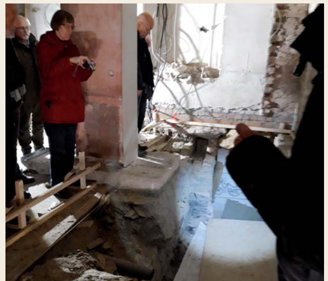
Blick in die antike Heizungsanlage
