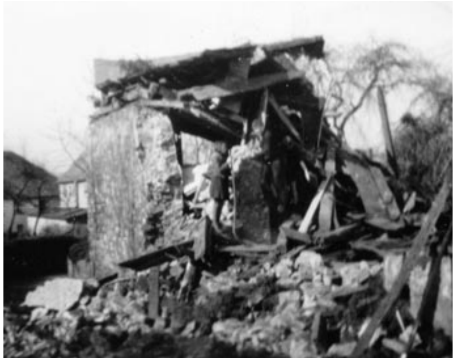
Alter Speicher an der Kirchenmauer nach Bombentreffer
