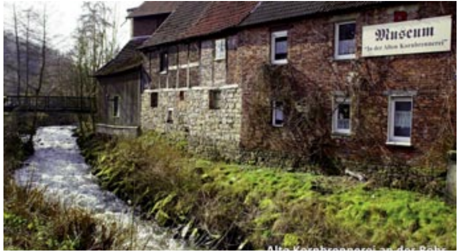
Das erstmals 1632 erwähnte Gebäude von der Röhr aus gesehen
