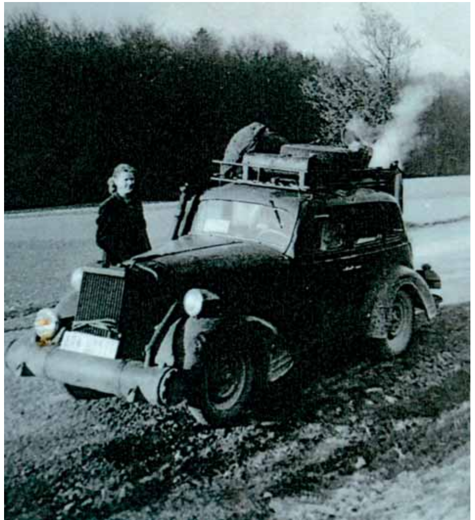
Da es so gut wie keinen Sprit gab, wurden die Autos umgebaut zu einem „Holzvergaser“, der während der Fahrt nach einer gewissen Zeit „gestochert“ werden musste, um somit Dampf zu erzeugen, der über eine Schlauchleitung nach vorn zum Motor geführt wurde.
