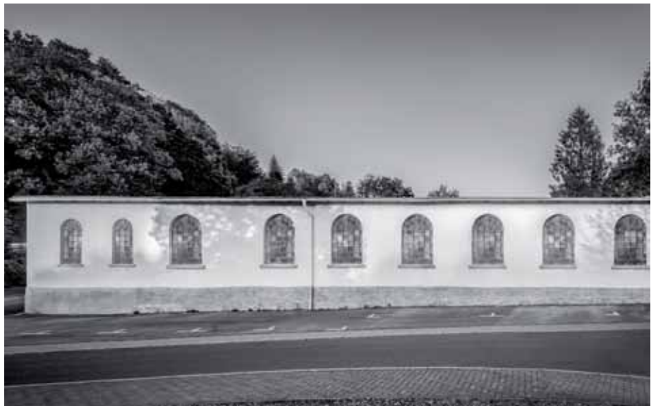
Fassade der Fabrik am Schwemker Ring – von 1931-1971 Sitz der Firma Gebrüder Schulte – heute Betriebshof der Stadt Sundern
