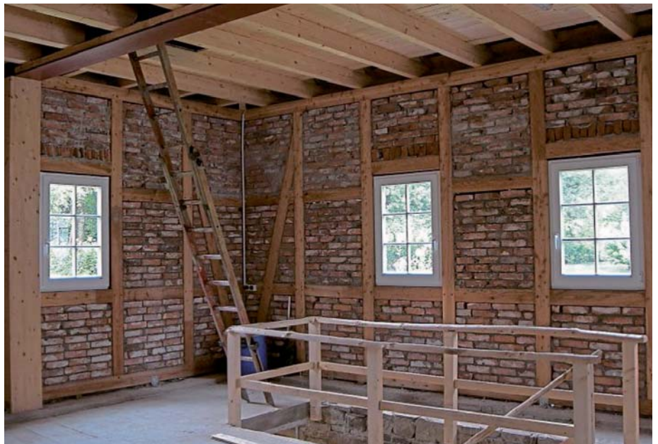
Im Obergeschoss ist ein rund 90 m² großer Raum entstanden. Die Nutzung ist noch ungewiss, eines aber klar: „Für ein Lager oder eine Werkstatt ist der Platz zu schade.“
