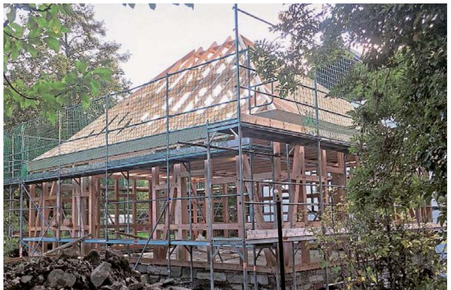
Ein Zimmermeister aus dem Nachbarort errichtete das neue Fachwerk. Innerhalb eines Tages stand das neue Gerüst am alten Standort.
