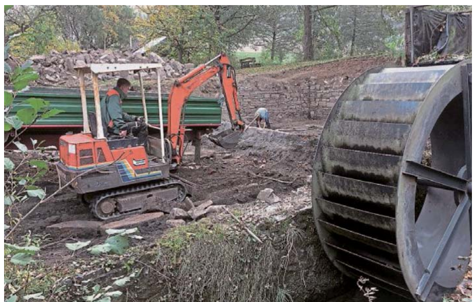
Mit einem Minibagger und von Hand wurden die Überreste der alten Mühle geborgen. Das neue Mühlrad aus Stahl ist Marke Eigenbau und vier Jahre alt.
