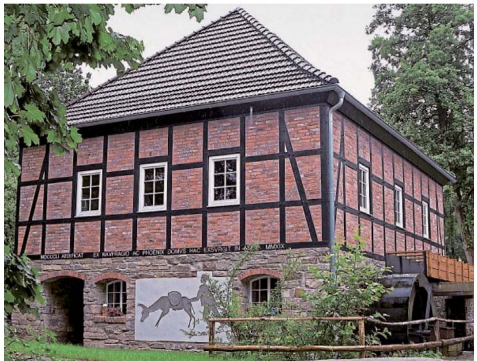
Das Gebäude steht auf einem Bruchstein-Sockel. Die Inschrift im Fachwerk bedeutet: „Aus den Trümmern erhebt sich dieses Haus wie Phoenix in die Höhe“.
