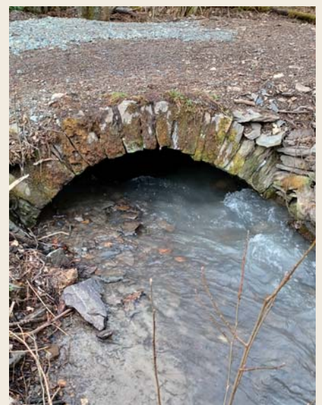
Nordseite noch im ursprünglichen Zustand
