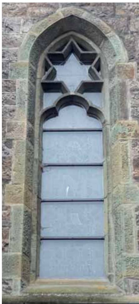
Von außen fügt sich das Fenster mit dem Davidstern eher unauffällig in die Fensterfront ein
