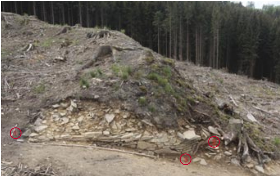
Abb. 4: Blick von Osten auf die westliche Torwange mit freigelegtem Fundamentbereich.
